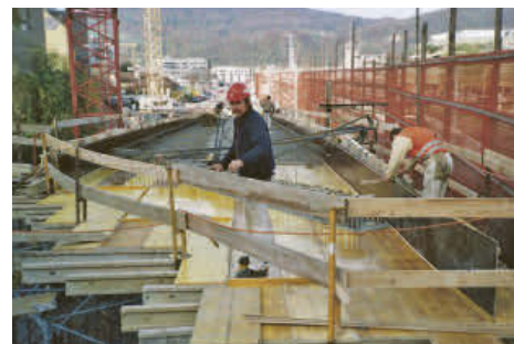
Markus Suter damals auf der Baustelle «Busrampe Baden».
